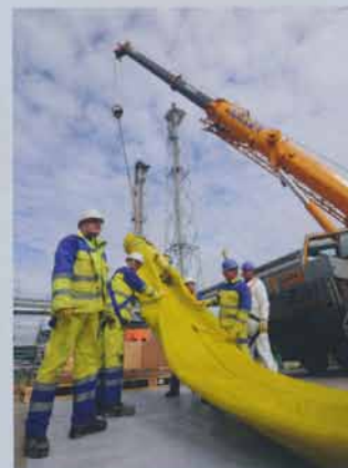
Bild 2: Wachstum mit gedämpfter Zuwachsrate: 2014 wurden 1373 km Schlauchliner in Abwasserkanäle > DN 200 eingebaut
