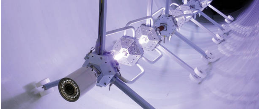
Lichtaushärtende Verfahren werden zunehmend bei der Sanierung von Abwasserrohren mit großen Nennweiten eingesetzt. Foto: RELINEEUROPE AG
