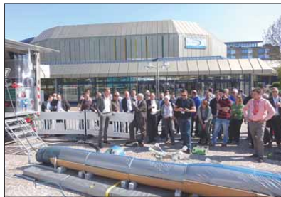
Die moderierten Außenvorführungen boten „Schlauchliniertechnik zum Anfassen“. Bild: TAH
