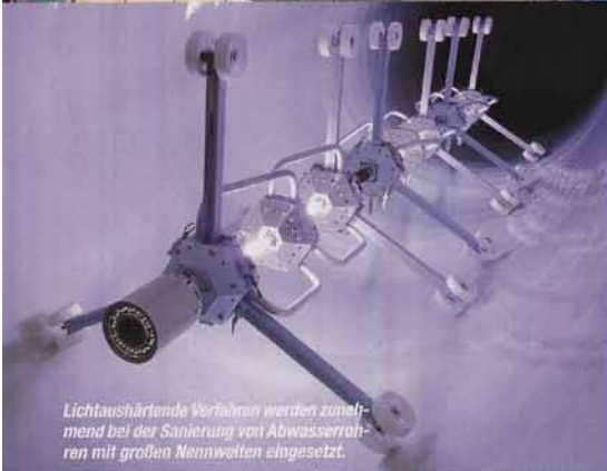
Einbau eines lichtaushärtenden GFK-Liners.
