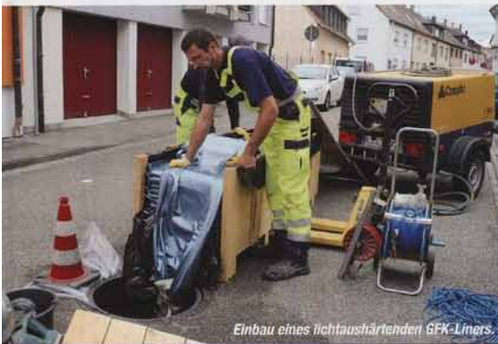
Einbau eines lichtaushärtenden GFK-Liners.
