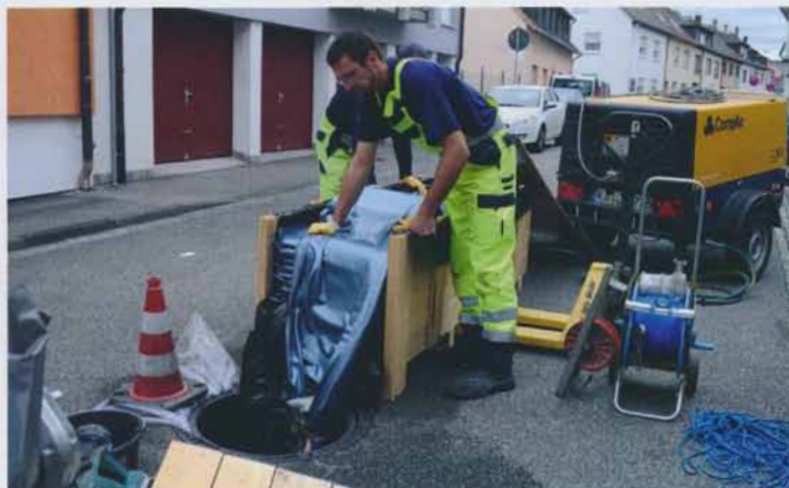
Einbau eines lichtaushärtenden GFK-Liners | Foto: Relineurope AG
