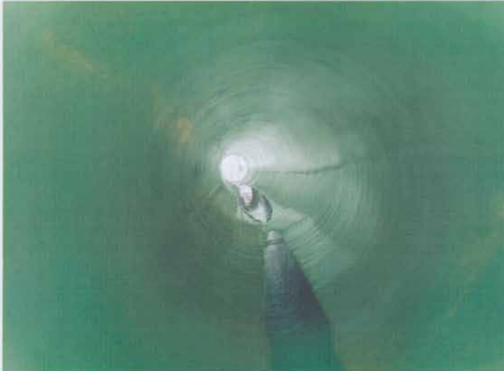
Die Sanierung mit einem Schlauchlinersystem schafft einen statisch tragfähigen, dichten und betriebssicheren Kanal. Bei Einhaltung der durch die Hersteller vorgegebenen Parameter entsteht ein Rohrsystem mit einer enormen Lebensdauer. | Foto: Brandenburger Liner GmbH & Co. KG
