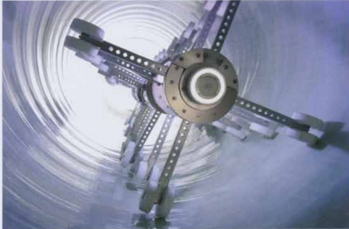
Mit der Entwicklung von UV-härtenden Glasfaserschläuchen wurde das Spektrum der Lösungen im Schlauchlinerbereich um eine interessante Variante bereichert. | Foto: Relineurope AG
