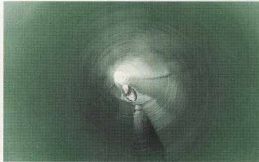
Die Schlauchlinersanierung schafft einen statisch tragfähigen, dichten und betriebssicheren Kanal und bei Einhaltung der vorgegebenen Parameter ein Rohrsystem mit enormer Lebensdauer. | Foto: Brandenburger Liner GmbH & Co. KG
