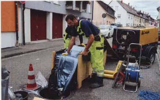
Einbau eines lichtaushärtenden GFK-Liners | Foto: Relineurope AG
