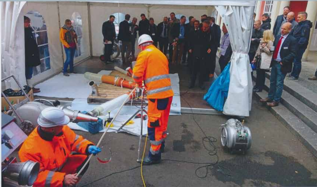
Bei den moderierten Außenvorfürungen konnten sich die Besucher des Kongresses anhand unterschiedlichster Anwendungsbeispiele mit eigenen Augen von den Vorteilen der Schlauchlinertechnologie überzeugen.
