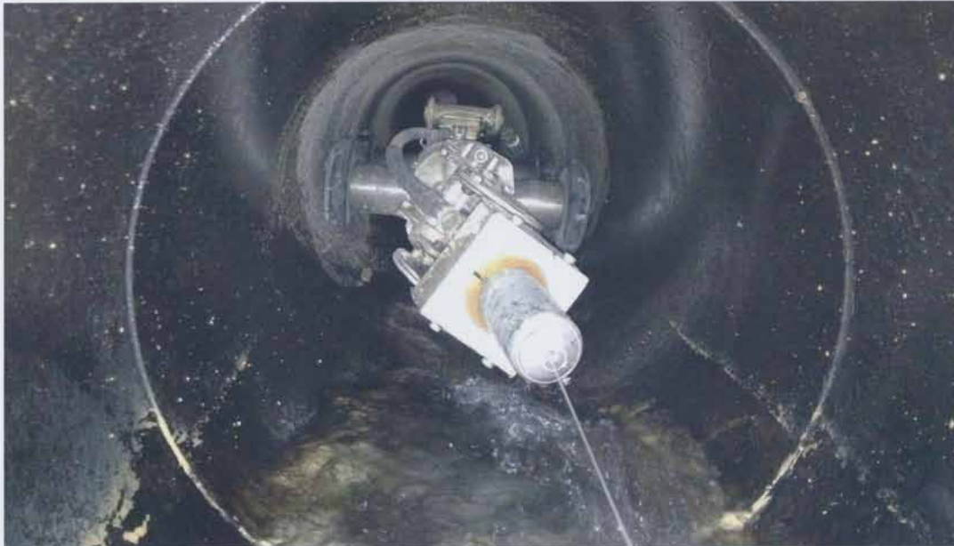
Entfernen von Inkrustation im Kanalsystem: Ein Höchstdruck-Wasserstrahlroboter wie der Drain-Jet Robotics dient zur Vorbereitung eines Hauptkanals für Reparaturmaßnahmen oder den Einzug von Schlauchlinern. | Foto: Mauerspecht GmbH
