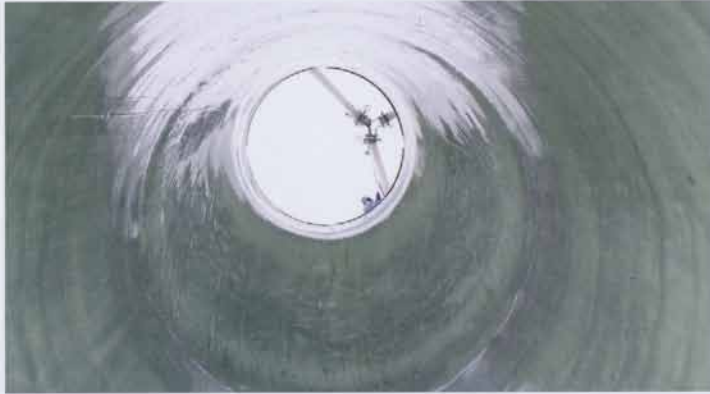
Ein dauerhaftes und zuverlässiges Sanierungsergebnis: Bei einer Schachtsanierung mit dem Vertiliner wird der Liner im Werk als Abbild des Schachtbauwerkes hergestellt. | Foto: Rohrsanierung Jensen
