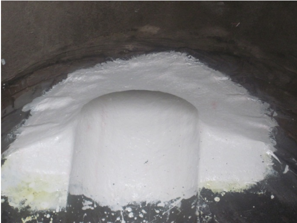
Bild 2: Schachtanbindung, GfK Handlaminat
