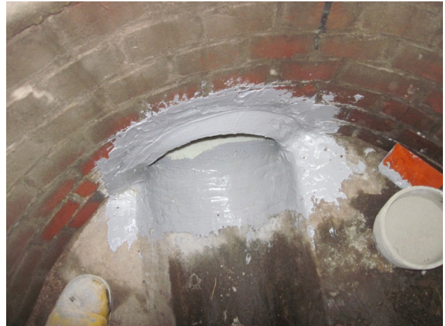
Bild 5: Verspachtelung des Überstandes
