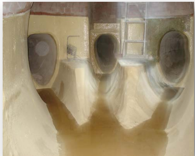
Bild 10: Schachtauskleidung mit GFK-Platten
