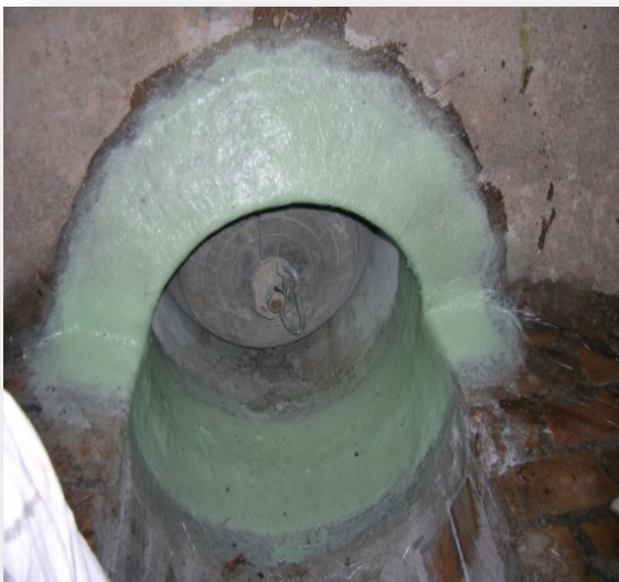
Bild 9: Spiegel aus Handlaminat
