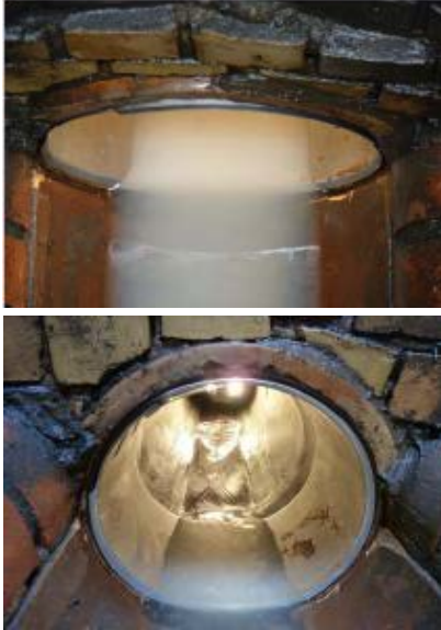
Einbau von Schlauchlinerendmanschetten Bild: quicklock
